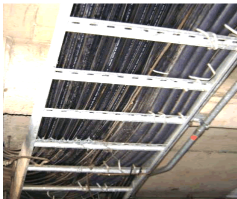
Imagen 8. Escalerilla porta-conductora compartiendo coaxiales y líneas de fuerza-alumbrado.
